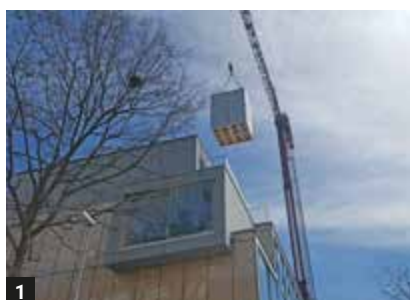
1 Kran-Ablad Déchargement avec grue
