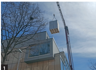
1 Kran-Ablad Déchargement avec grue
