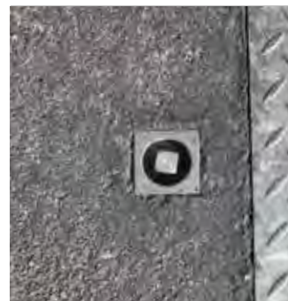
Schnellöffnung mittels Schraubvorreiber
