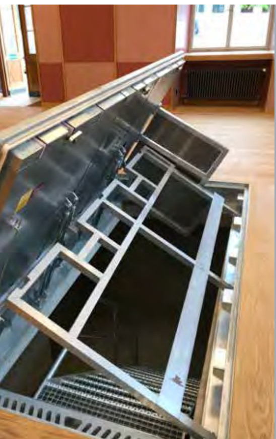
Notausstieg Wärmeversorgung Ibach Luzern
