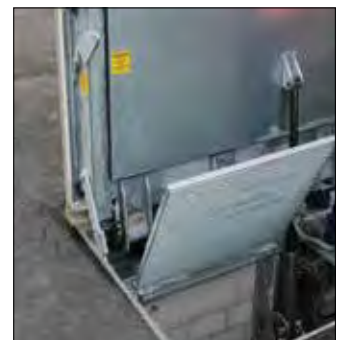
Absturzsicherung mittels Klapprost oder automatisch auffahrendes Geländer
