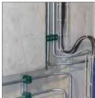
Elektro- und Hydraulikverrohrung
