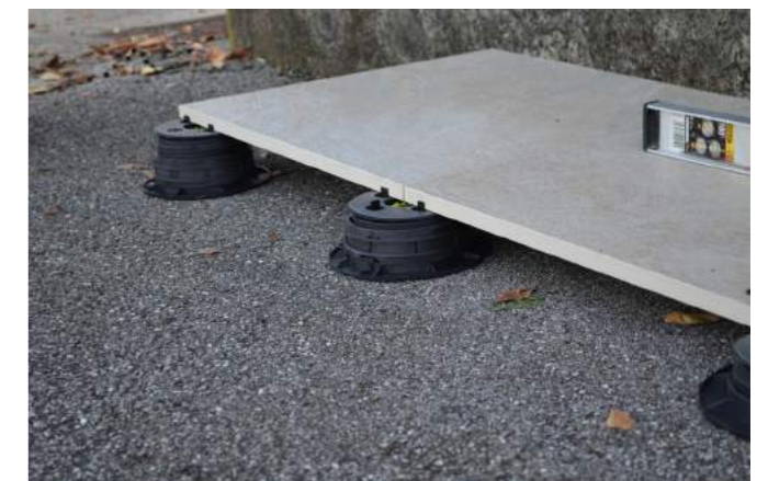
5. Platten aufsetzen, ausrichten, fertig!
