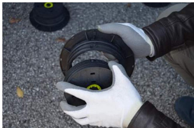
2. Basisteile zusammenschrauben
