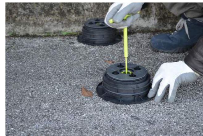
4. Stelzlager ausrichten (Kopf fix oder flexibel)
