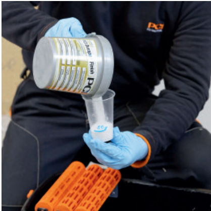
PCI Durapox Finish (Konzentrat) in das Waschwasser zumischen. Mischungsverhältnis 1 : 100.
