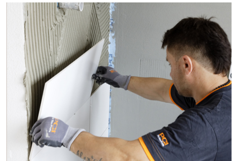
Mit PCI FT Extra können Fliesen auf der Verbundabdichtung PCI Lastogum ® sicher verlegt werden.
