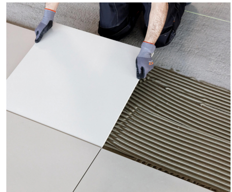
Verlegen von Feinsteinzeugplatten.
