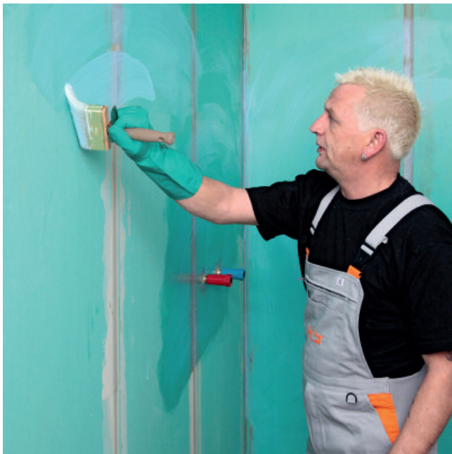
1. Grundieren: Saugende mineralische oder gipshaltige Untergründe und Gipskartonplatten mit PCI Gisogrund grundieren.
