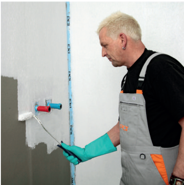
5. Zweite Schutzschicht mit PCI Lastogum (weiß) nach einer Ablüftezeit von ca. 1 Stunde aufbringen. Ein Durchscheinen des 1. Auftrags mit PCI Lastogum (weiß) ist zu vermeiden, erforderlichenfalls nochmals überarbeiten.
