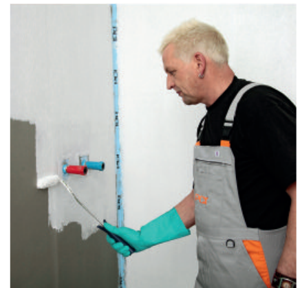
PCI Lastogum wird unverdünnt durch Rollen, Streichen oder Spachteln auf den Untergrund aufgebracht.
