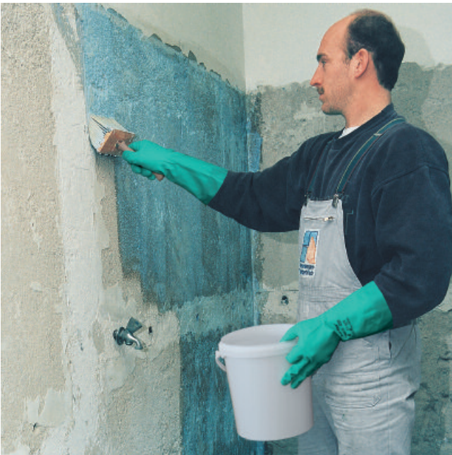
PCI Gisogrund verbessert die Festigkeit und Tragfähigkeit alter, sandender Putze und erhöht die Haftung von Fliesen, Putzen und Tapeten.
