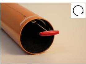
c) Schraube in Pfeilrichtung mit originalwerkzeug fixieren. Die Schraube muss im Scheitelbereich Fixiert werden.
