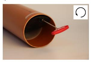
Schraube in Pfeilrichtung c) (Gegenuhrzeigersinn) fixieren. Um ein optimales Funktionieren zu garantieren, muss die Schraube im Scheitelbereich der Röhre fixiert werden.
