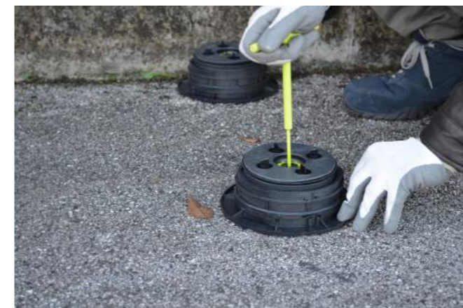
4. Stelzlager ausrichten (Kopf fix oder flexibel)
