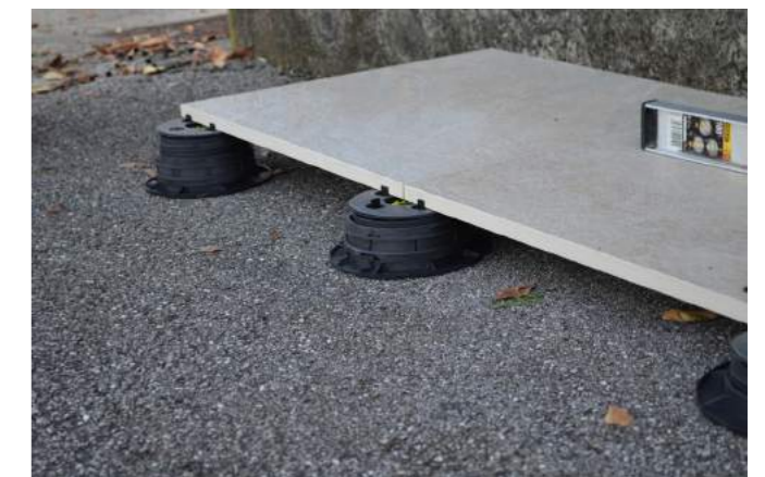
5. Platten aufsetzen, ausrichten, fertig!
