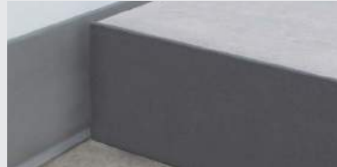
D-4. Die Platte zur Abdeckung verlegen.
