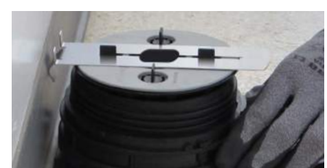
6. Den Randabstandshalter SUPACLPP zwischen den Abstandshaltern des Stelzlagers und mit Kontakt zur Wand anbringen.
