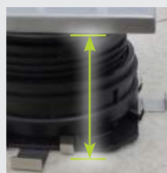
F-4. Die Platte entsprechend dem Abstand zwischen dem Profil BSJ und dem Clip SUPACLPB zuschneiden.
