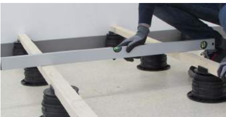
22. Überprüfen, dass die Installation nivelliert ist.
