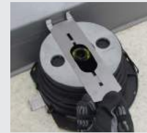
D-3. Den Randabstandshalter SUPACLPP und das Profil BSJ auf dem Kopf des Stezlagers positionieren.
