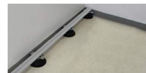
9. Sicherstellen, dass die Aluschiene fest auf jedem Stelzlager sitzt.
