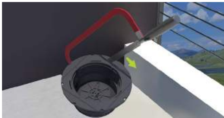
1. Eine der Trägerseite abschneiden.
