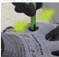
10. Die anderen beiden Abstandshalter mit dem Schlüssel SUPAK entfernen.
