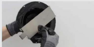
E-1. Den Clip SUPACLPB unter dem Basisteil des Stezlagers positionieren.
