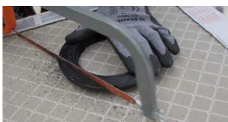
4. Das Basisteil umdrehen und an einer Seite entlang der Perforierung abschneiden.
