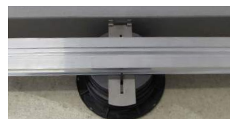
8. Die Schiene zwischen die Abstandshalter der restlichen Stelzlager stecken.
