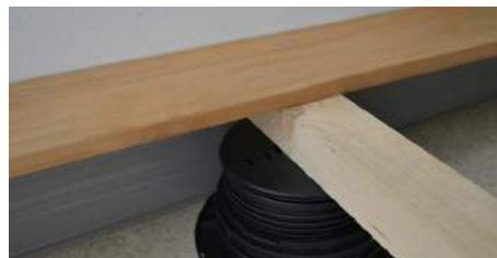
23. Die erste Holzdielen an der Wand anlegen.
