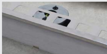
E-5. Das zugeschnittene Stück zwischen dem Profil BSJ und dem Clip SUPACLPB einklemmen.
