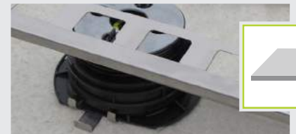
E-3. Das Profil BSJ auf dem Kopf des Stezlagers positionieren
