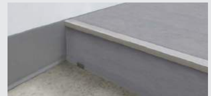
D-6. Die Platte zur Abdeckung verlegen.
