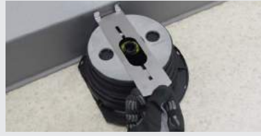
D-2. Den Abstandhalter-Clip SUPACLPP auf den Trägerkopf positionieren.
