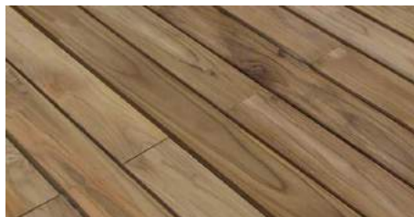
26. Die restlichen Dielen verlegen und befestigen.
