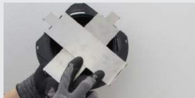
F-1. Zwei Clips SUPACLPB über Kreuz unter dem Basisteil des Stezlagers positionieren.
