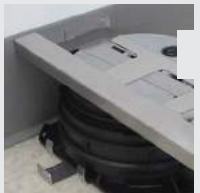
D-3. Den Randabstandshalter SUPACLPP und das Profil BSJ auf dem Kopf des Stezlagers positionieren.
