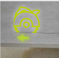
E-4. Die Platte entsprechend dem Abstand zwischen dem Profil BSJ und dem Clip SUPACLPB zuschneiden.
