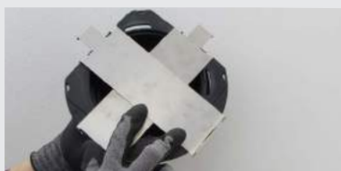
F-1. Zwei Clips SUPACLPB über Kreuz unter dem Basisteil des Stelzagers positionieren.
