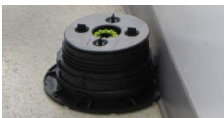
8. Das Stelzlager zusammenbauen und mit der abgeschnittenen Seite an der Wand positionieren.
