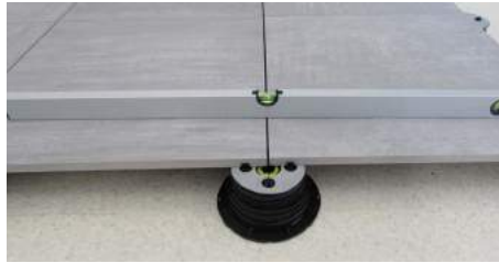
16. Überprüfen, ob der Bodenbelag gerade ist.
