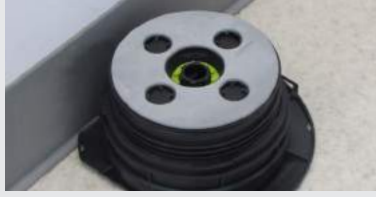
D-1. Das Stelzlager mit einer abgeschnittenen Seite zur Wand und mit der anderen Seite nach außen positionieren.
