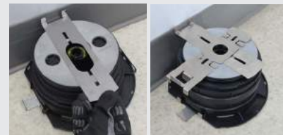
D-3. Den Clip SUPACLPT senkrecht zur Wand positionieren. Den Clip für den Kopf SUPACLPT positionieren.
