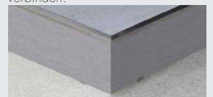
F-6. Die Platte zur Abdeckung verlegen.
