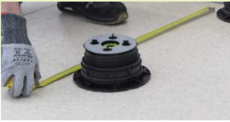
12. Die Mitte der Stelzlager entsprechend der Plattengröße positionieren. Maximaler Abstand: 60 cm
