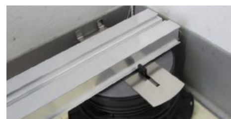
7. Die Aluschiene SUPAAN auf die Abstandshalter SUPA4 aufstecken.
