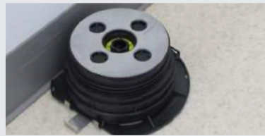
D-2. Das Stezlager mit einer abgeschnittenen Seite an der Wand und mit der anderen Seite nach außen positionieren.
