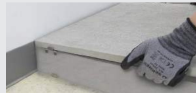
D-6. Die Platte zur Abdeckung verlegen.
