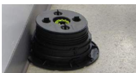
5. Das Stelzlager zusammenbauen und die abgeschnittene Seite an der Wand positionieren.
