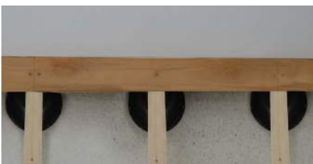
25. Die erste Reihe Holzdielen verlegen und an den Kontaktpunkten mit dem Holzbalken verschrauben.
