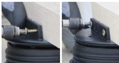
20. Den Balken am Träger mit den vorgesehenen Schlitzte anschrauben.
