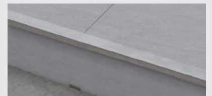
E-6. Die Platte zur Abdeckung verlegen.
