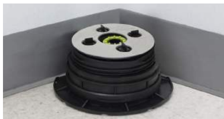
2. Das Stelzlager zusammenbauen und in der Ecke positionieren.
