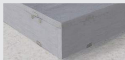
F-6. Die Platte zur Abdeckung verlegen.
