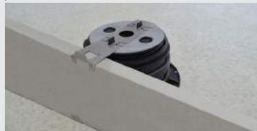
E-5. Das zugeschnittene Stück zwischen den Clips SUPACLPT und SUPACLPB einklemmen.
