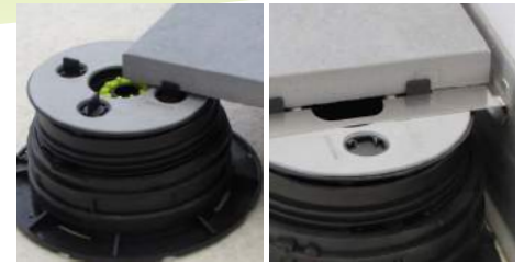
14. Die Eckpunkte der Platte zwischen den Abstandhaltern ablegen.
