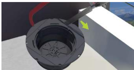
13. Eine der Trägerseite abschneiden.
