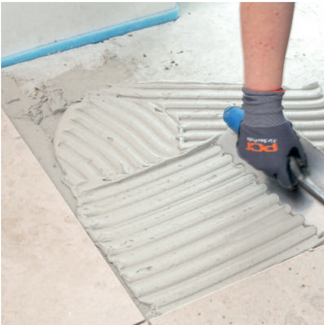
PCI Carrament® weiß ist ein plastisch-geschmeidiger Mittelbettmörtel und lässt sich leicht auftragen.
