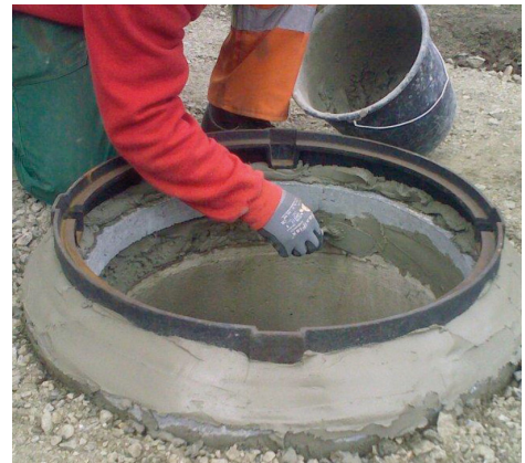
Schachtabdeckungen lassen sich zeitsparend mit PCI Polyfix plus setzen.
